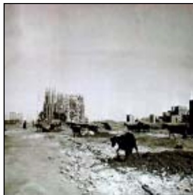
C.Comas: La Sagrada Familia en construcción, c/1905. (20_14_1cr)
