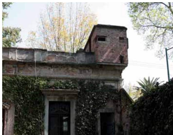
Fotografies de les modificacions que va patir la casa, després de l'atemptat de Siqueiros: nous torreons de vigilància interiors (el de sota de tot és el que ja hi era, que controlava el carrer); finestres tapiades, portes reduïdes i blindades; l'entrada per a visitants també tapiada i oberta una altra de lateral... tot per garantir la seguretat de Trotski. Fotografies de l'autor.
