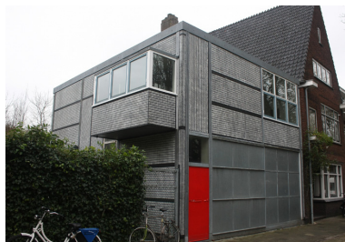
Garaje y pequeña vivienda para chofer, Utrecht 1927. Fotografía de la época y estado actual (restaurado).
