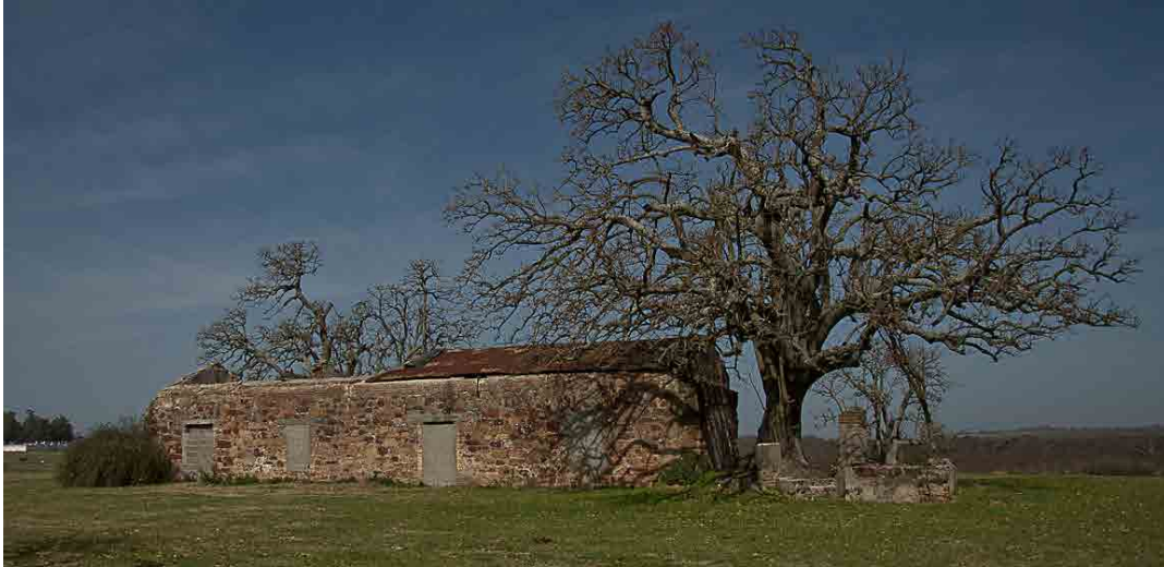
Figura 66- Restos de la Calera Dacá en la margen uruguaya, sobre el río Negro Foto del Servicio de Medios Audiovisuales- Facultad de Arquitectura
