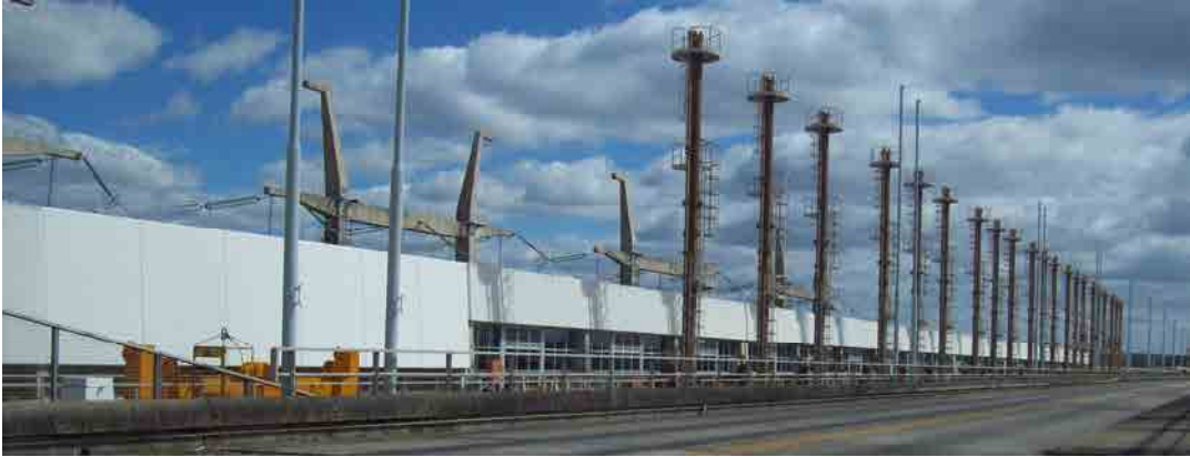
Figura 120- Puente sobre la Represa Hidroeléctrica de Salto Grande Foto Pablo Núñez
