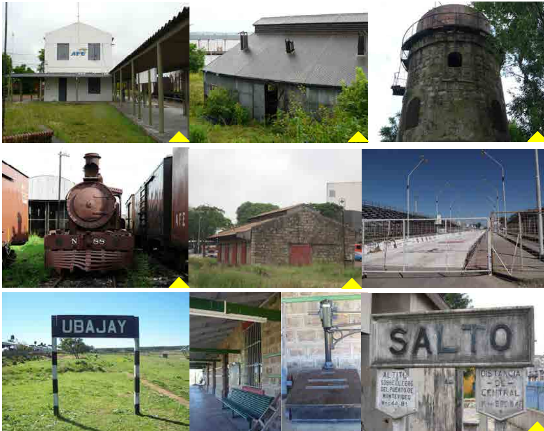
Figura 25- Equipamiento ferroviario, trazas en el territorio
