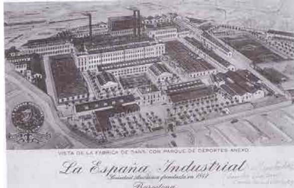
Fig.13 Fábrica de Sans con Parque de Deportes anexo
