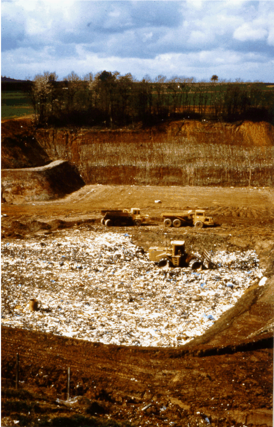
Fotografía 3. Relleno o vertido en celdas en el vertedero de Soignolles en Brie (Metz, Francia)
