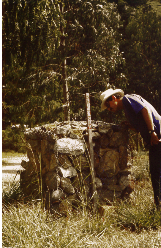
Fotografía 9b. Distintas chimeneas de venteo del biogás: (b) Curva de Rodas, Medellín
