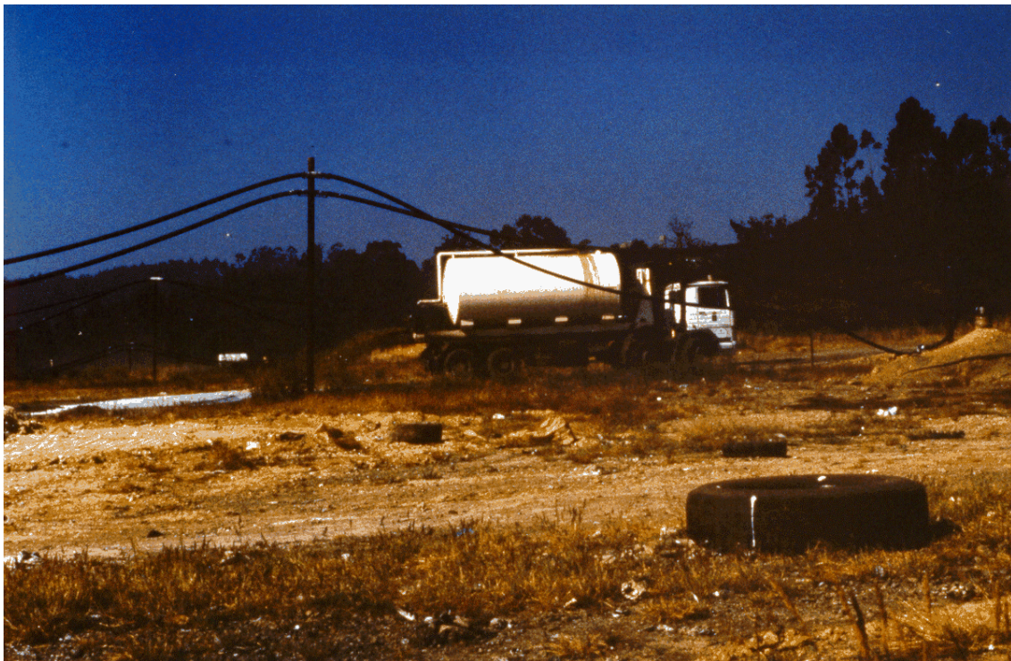
Fotografía 2. Recirculación de lixiviados en periodos secos (La Zoreda)
