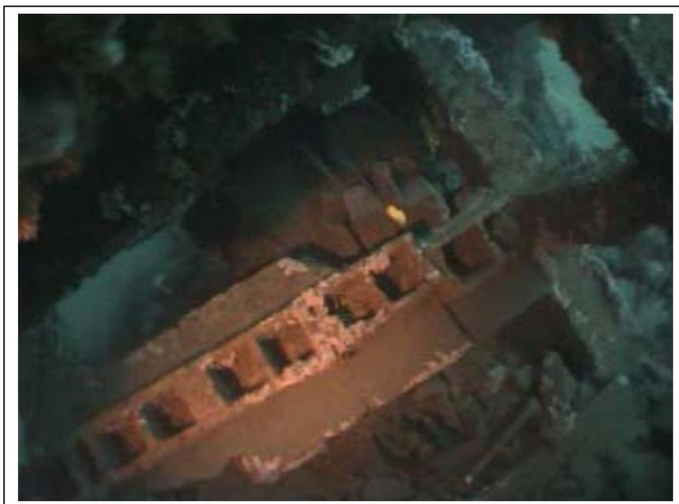
**Figura 44. Detalle del estado de uno de los alvéolos del arrecife de Cudillero**
