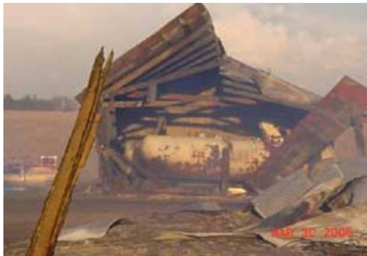
FIGURA 3.12. Fragmento de un tanque de GLP que destruye un almacén en una explosión en Monmouth (Illinois) en 2005 (Anderson, 2005).
