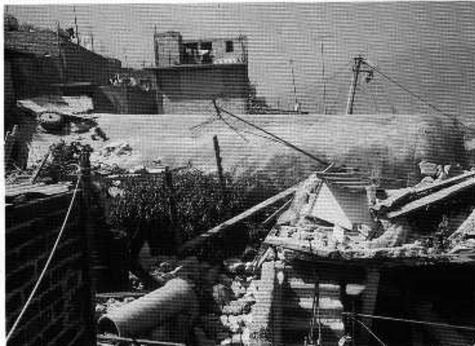
FIGURA 3.9. Fragmento de un recipiente que destruye una vivienda en la explosión de San Juan Ixhuatepec en 1984 (Hawrelak, 1999).
