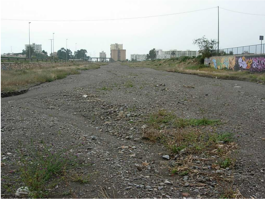
Fig. II.113 Encauzamiento de la rambla del Renegado a su llegada a la ciudad de Águilas.
