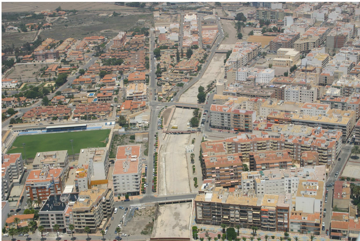
Fig. II.110 Canalización de la rambla Peñaranda-Labradorcico a su paso por la ciudad de Águilas.
