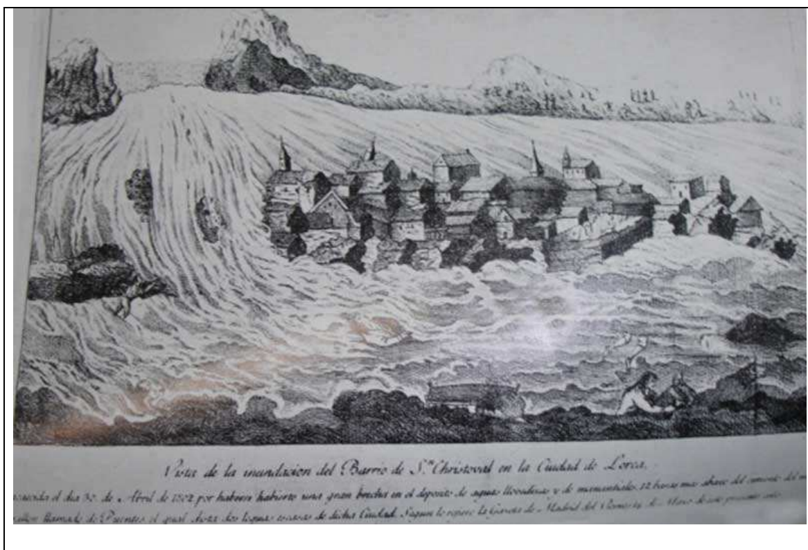
Fig. III.11 Detalle del barrio de San Cristóbal durante la avenida ocasionada por la rotura de Puentes en un grabado de la época. Fuente: www.regmurcia.com
