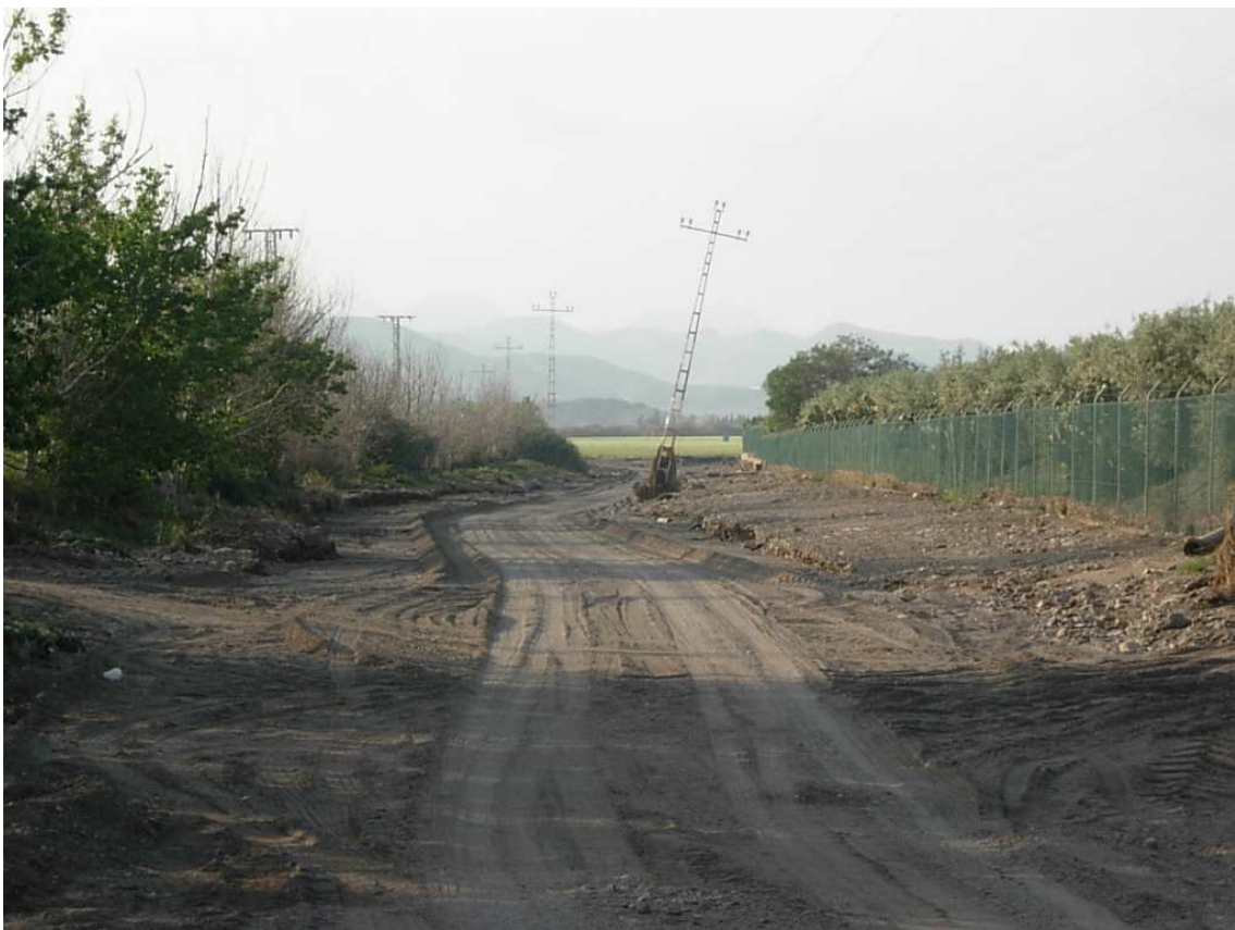
Fig. II.120 Cauce del ramal de la rambla de Cañarete que desemboca en Matalentisco
