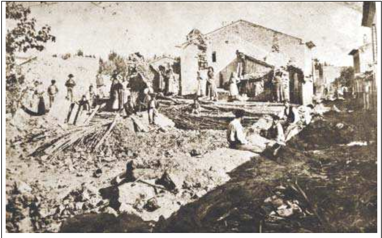
Fig. III.16 Viviendas destrozadas por la riada en la Huerta de Murcia. La imagen fue tomada en Rincón de Beniscornia días después de la catástrofe. En ella se advierte como la población volvía a sus casas para recuperar cualquier objeto de valor que no hubiese sido arrastrado por las aguas. Fuente: www.regmurcia.com
