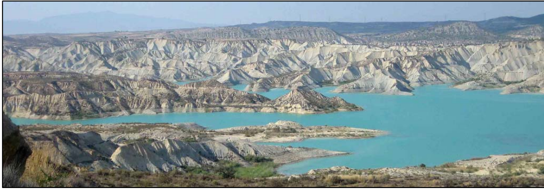
Fig. 103. Embalse de la rambla de Algeciras, finalizado en diciembre de 1995. Además de laminar las aguas de avenida procedentes de la vertiente Este de sierra Espuña, cumple la función de regular las que circulan por el canal principal de la margen derecha del trasvase Tajo-Segura, que abastecen a la zona regable del Guadalentín
