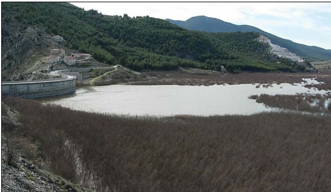
Fig. 45. Embalse de Valdeinfierno. Obsérvese el alto grado de colmatación sedimentaria (2007)
