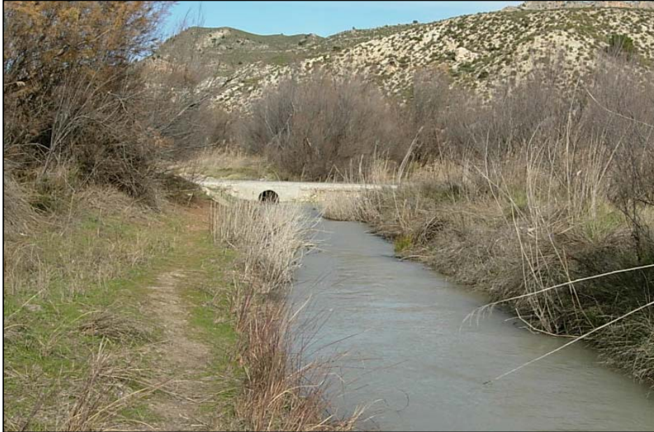
Fig. 42. Río-rambla Luchena, aguas abajo del embalse de Valdeinfierno
