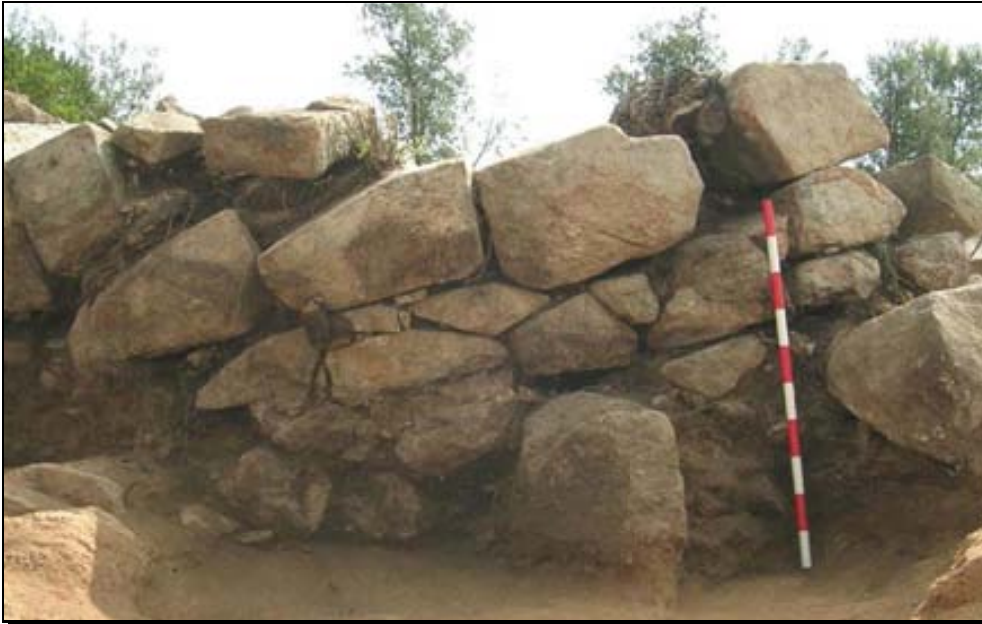
Figura 121: detall del parament exterior oest de la Torre del Far.
