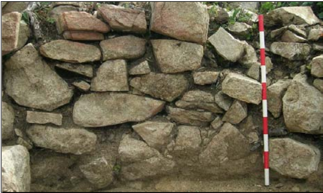
Figura 122: detall del parament interior de la Torre del Far.
