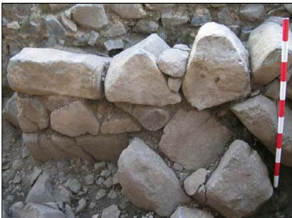
Figura 190: detall de les pedres de basalt lligades amb morter de calç que formen un mur (UE 1045) del castell de Malavella.
