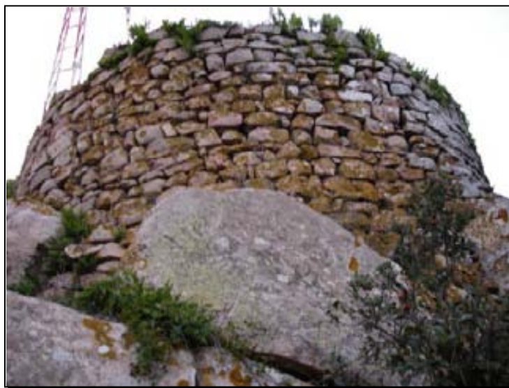
Figura 140: detall d'una part del parament exterior d'una torre del Castell de Montagut on possiblement se situaria ipso Far (Llagostera).
