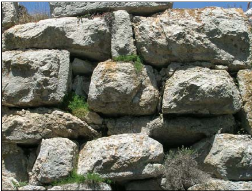
Figura 133: detall del parament exterior de la Torre de Falgars.
