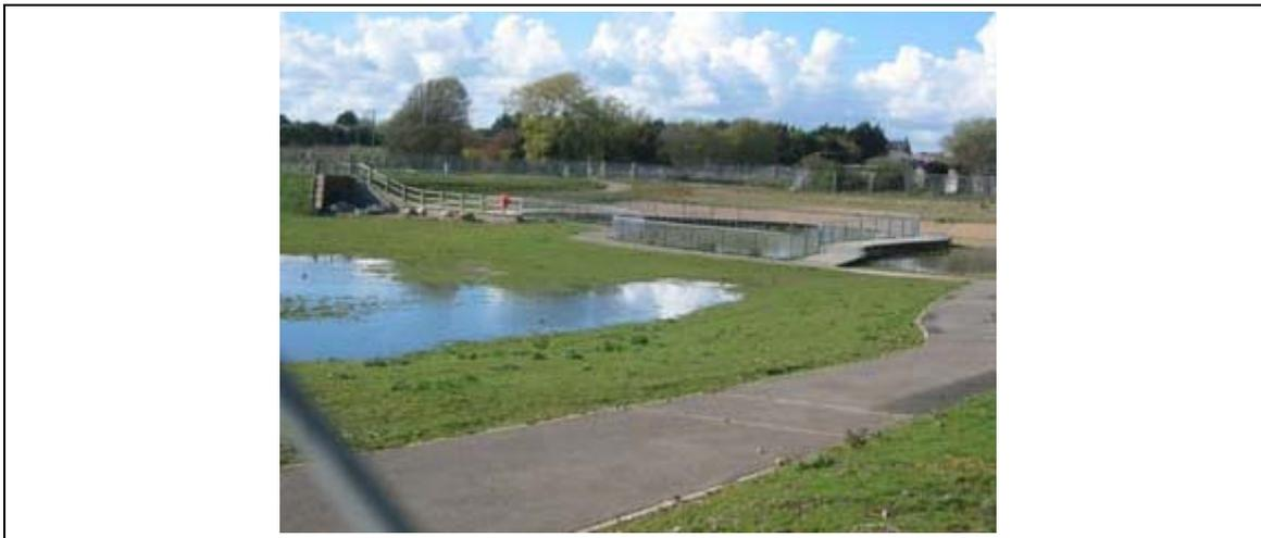
Figura 2.4. Depósitos de infiltración (Perales Momparler y Andrés-Doménech 2008).
