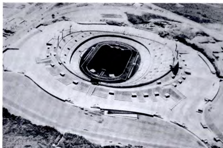
01. Estadio Azteca, 1966. Pedro Ramírez Vázquez, Rafael Mijares y Luis Martínez del Campo. En: Baumeister . Vol 65, Marzo 1968.
