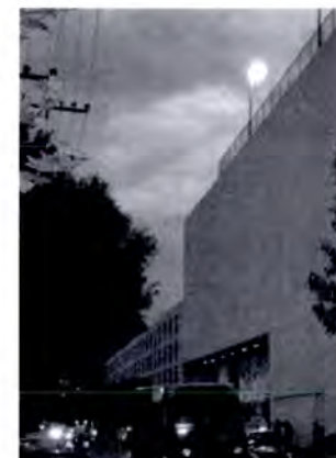
100a. 100b. Cilindros perimetrales del Hotel Camino Real. Fotografías: Lourdes Legorreta. Cedidas por el archivo Legorreta Arquitectos.
