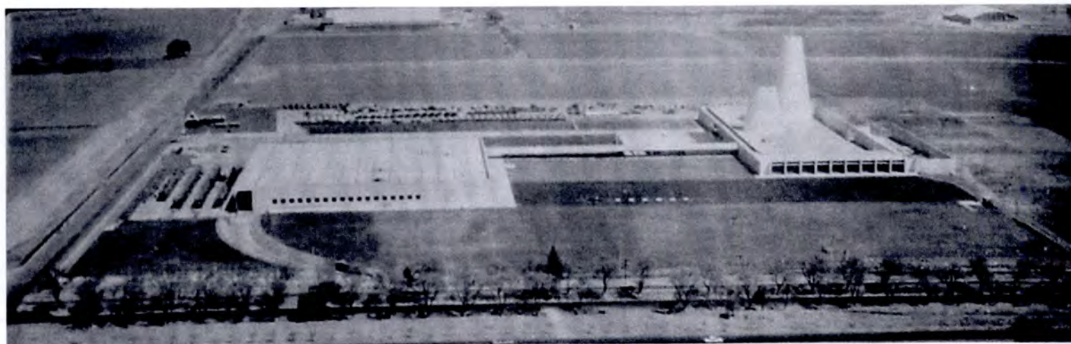
06. Vista aérea del conjunto Automex, Primera Fase. En: Arquitectos de México Núm. 28. Agosto 1967.
