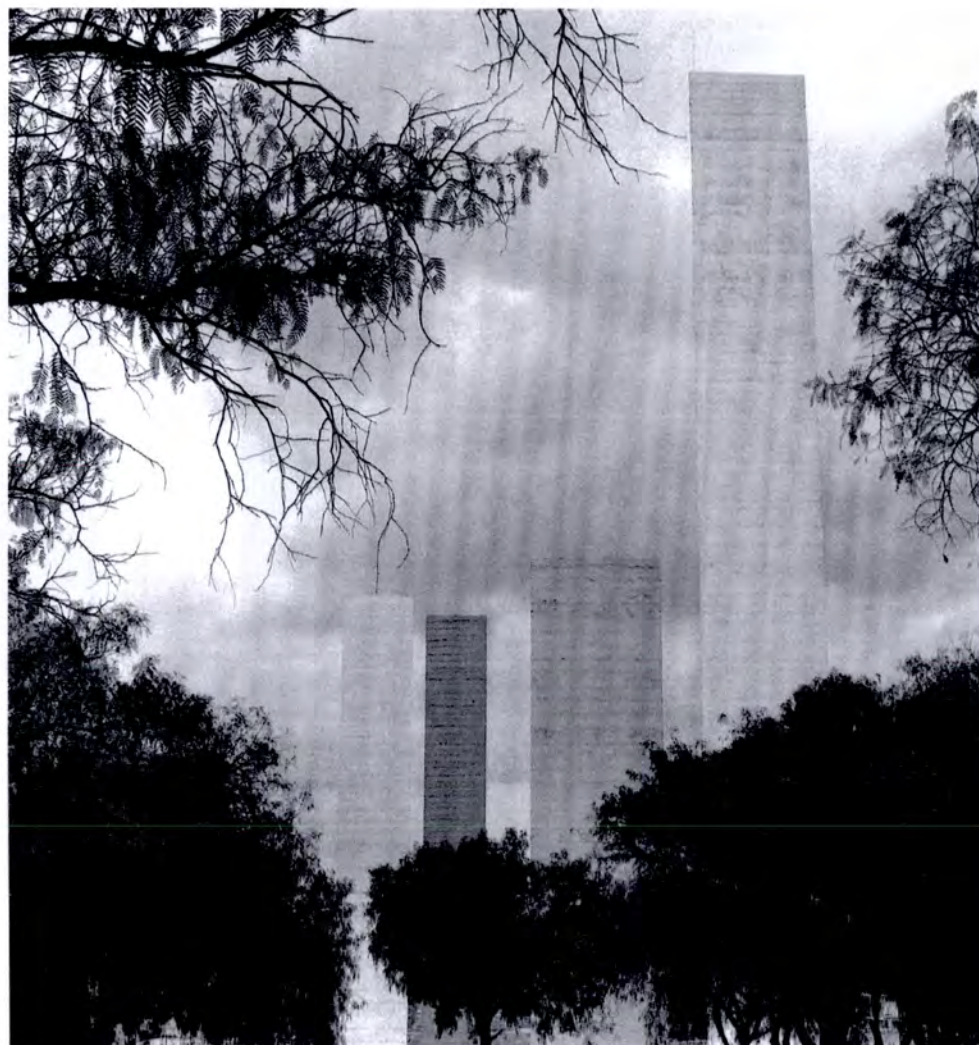
46. Torres de Satélite, vista deformada a la altura humana. Es fundamental el recorrido rodado para percibir las Torres de una forma u otra. Fotografía: Armando Salas Portugal. Barragán Foundation . En: ZANCO, Federica. Luis Barragán The Quiet Revolution . 2001
