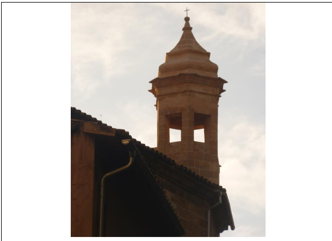
Figura 15. Torre de la Iglesia de Santa Teresa
