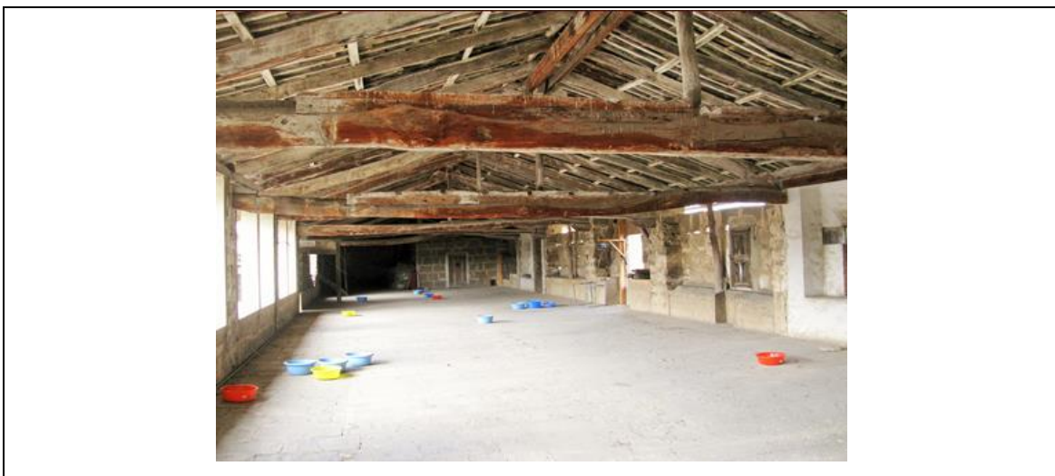
Figura 157. Convento de la Purísima Concepción (interior)
