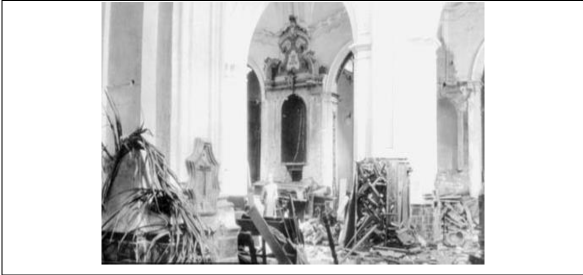
Figura 1. Destrucción de la iglesia de San Juan (Málaga)
