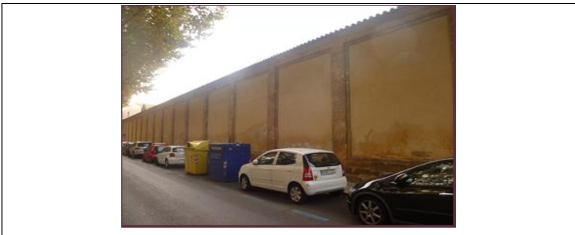
Figura 153. Muro de cierre del convento de Santa Magdalena
